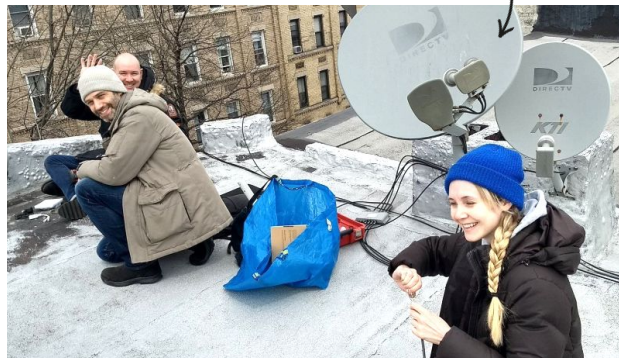
Voluntarios instalando NYC Mesh
